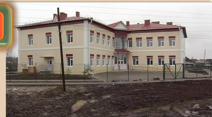
Строительство школы в с. Нижняя Тига
