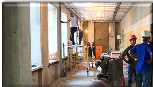
Обская библиотека - филиал Капитальный ремонт помещения
