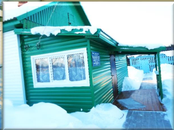
Обшивка фасада здания и замена окон филиала МБОУ «Новоколоминская СОШ» «Обская НОШ» 521,6 тыс. руб.
