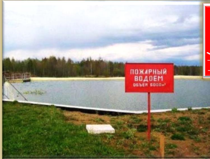
Устройство пожарного водоема для МБОУ ДО «Чаинская ДЮСШ» 48,0 тыс. руб.
