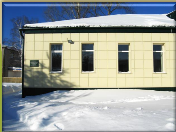
Ремонт фасада здания МБОУ ДО «Подгорнская ДХШ» 1370,2 тыс. руб.
