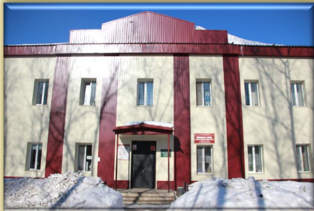
Капитальный ремонт системы отопления МБУК «МЦБС» 998,1 тыс. руб.
