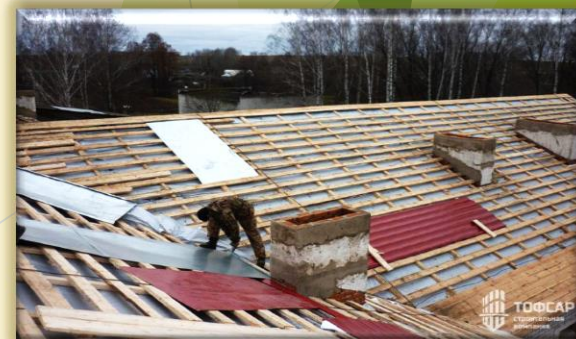
Замена кровельного перекрытия в здании МБОУ ДО «Чайинский ДДТ» 576,1 тыс. руб.
