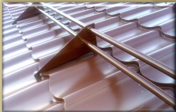
Обследование дымогарных труб и монтаж снегозадержателей кровли в МБДОУ «Подгорнский детский сад «Берёзка» 316,0 тыс. руб.
